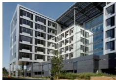
Green Office™ à Meudon (France), l'un des premiers immeubles de bureaux à énergie positive (23,000 m 2 )
