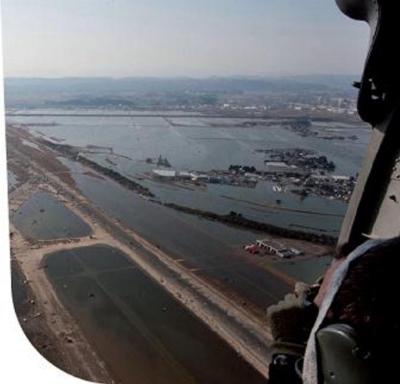
Vuelo sobre el Aeropuerto de Sendai en Japón después del tsunami
