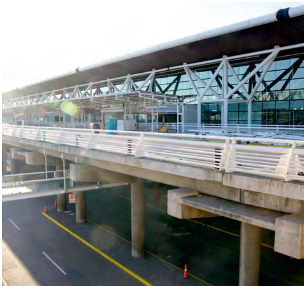
Figura 9. Las nuevas terminales del aeropuerto internacional de Santiago de Chile (a la izquierda) y del aeropuerto de Sendai (a la derecha). Ambas estructuras sufrieron ligeros daños estructurales, pero graves daños no estructurales y largas interrupciones de actividad. Se puede observar que las fachadas de cristal de ambos edificios se mantuvieron intactas, lo que demuestra la calidad del diseño estructural. La primera planta de la terminal de Sendai fue muy deteriorada por el tsunami (parte inferior del primer plano).
