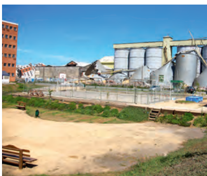
Figura 10. En la fotografía superior aparecen tres estructuras adyacentes en Concepción, Chile, después del terremoto de 2010. Los silos de acero derrumbados que están en primer plano son mucho más recientes que los silos de acero, mucho menos deteriorados y muchos más antiguos, situados detrás. El edificio ligeramente dañado, a la izquierda de la fotografía, es el mismo que se puede ver en la fotografía de en medio. Es mucho más antiguo que el edificio de viviendas nuevo y alto, totalmente destruido, que se observa en la tercera fotografía.
