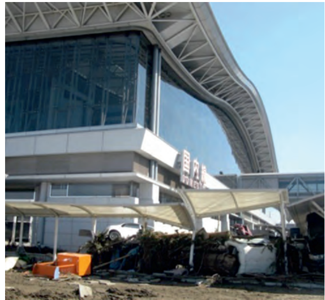
Figura 9. Las nuevas terminales del aeropuerto internacional de Santiago de Chile (a la izquierda) y del aeropuerto de Sendai (a la derecha). Ambas estructuras sufrieron ligeros daños estructurales, pero graves daños no estructurales y largas interrupciones de actividad. Se puede observar que las fachadas de cristal de ambos edificios se mantuvieron intactas, lo que demuestra la calidad del diseño estructural. La primera planta de la terminal de Sendai fue muy deteriorada por el tsunami (parte inferior del primer plano).
