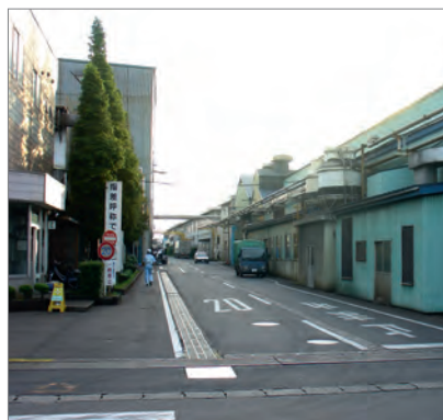
Figura 6. Algunas de las estructuras que se mantuvieron intactas o quedaron ligeramente dañadas en la planta de fabricación de aros de pistón.
