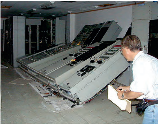
Figura 5. Equipo eléctrico sin fijar, caído durante el terremoto de M 7,6 ocurrido en el centro de Taiwán en 1999. Se muestra la solución (pernos de anclaje) en la parte derecha de la fotografía de la derecha. Este armario informático se encuentra al lado de otro que no está fijo y que se caerá en caso de fuerte terremoto. Ambos armarios forman parte del sistema de control de una importante red de metro en Estados Unidos.
