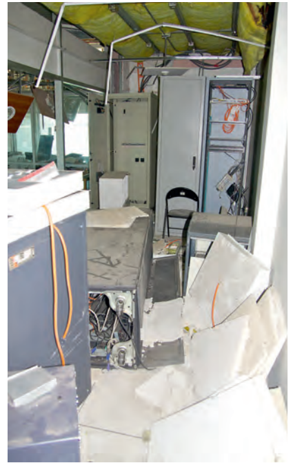
Figura 3. Daños en un centro de control de transportes situado en el interior de un edificio no dañado en Concepción, Chile. Se puede comprobar que la fachada de cristal del edificio ha quedado intacta (segunda fotografía a la izquierda), y que la sala informática que contenía los servidores, los armarios y demás equipos relacionados, inadecuadamente fijados o anclados, han sido destruidos.
