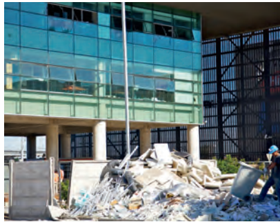
Figura 3. Daños en un centro de control de transportes situado en el interior de un edificio no dañado en Concepción, Chile. Se puede comprobar que la fachada de cristal del edificio ha quedado intacta (segunda fotografía a la izquierda), y que la sala informática que contenía los servidores, los armarios y demás equipos relacionados, inadecuadamente fijados o anclados, han sido destruidos.
