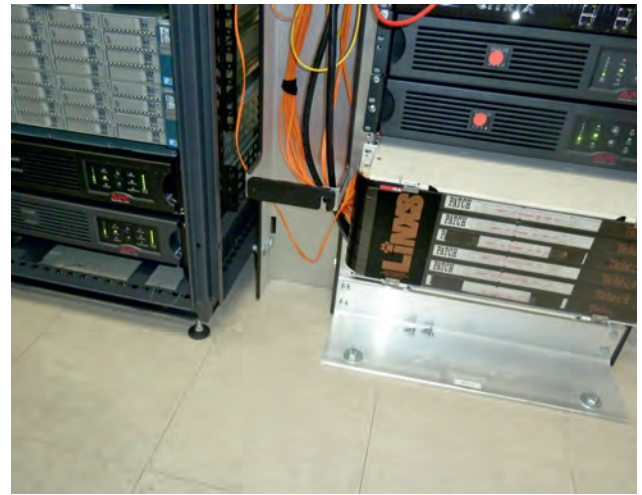
Figura 5. Equipo eléctrico sin fijar, caído durante el terremoto de M 7,6 ocurrido en el centro de Taiwán en 1999. Se muestra la solución (pernos de anclaje) en la parte derecha de la fotografía de la derecha. Este armario informático se encuentra al lado de otro que no está fijo y que se caerá en caso de fuerte terremoto. Ambos armarios forman parte del sistema de control de una importante red de metro en Estados Unidos.
