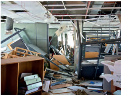
Figura 3. Daños en un centro de control de transportes situado en el interior de un edificio no dañado en Concepción, Chile. Se puede comprobar que la fachada de cristal del edificio ha quedado intacta (segunda fotografía a la izquierda), y que la sala informática que contenía los servidores, los armarios y demás equipos relacionados, inadecuadamente fijados o anclados, han sido destruidos.
