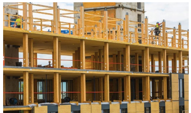
FIGURE 6 - STRUCTURE POTEAUX-POUTRES AVEC PLANCHERS EN CLT ET FAÇADE EN OSSATURE BOIS (FOB)
