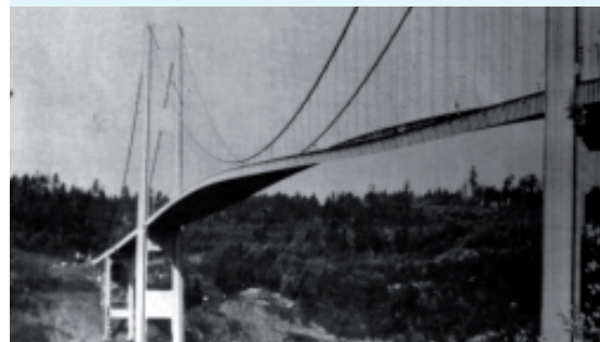
Figure 4 : Pont de Tacoma – Flottement en torsion avant destruction du tablier
